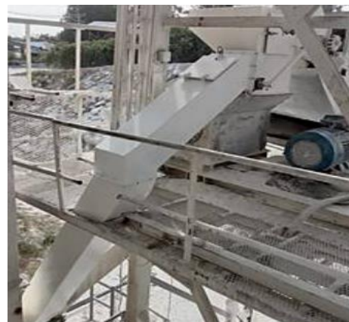
งานสร้าง Feed Chute
